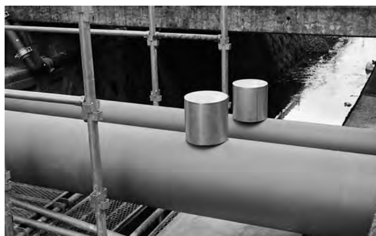
水管橋への施工
