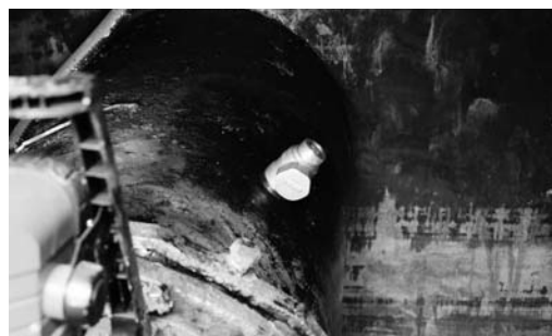
設置を完了した状態
